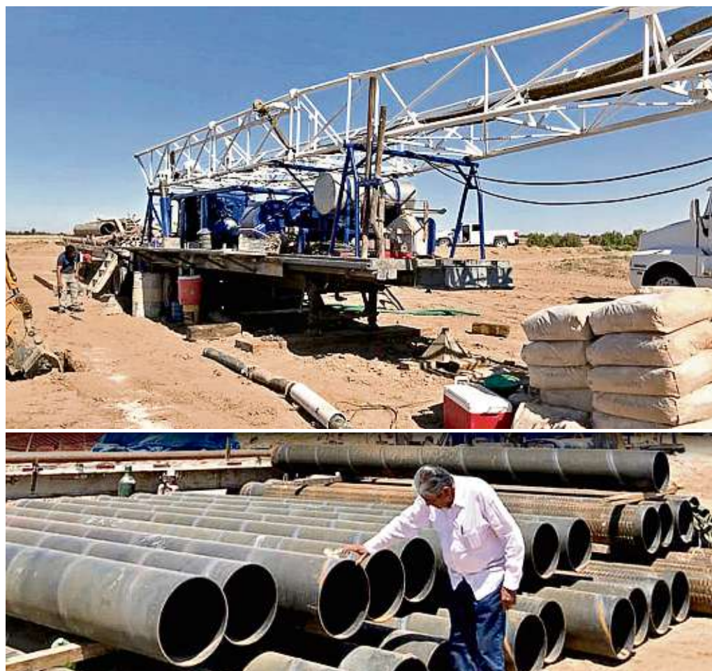
PROFUNDO. Instalación de maquinaria y equipo de perforación de un pozo en el Módulo de Riego 1, de San Luis Río Colorado, Sonora.
